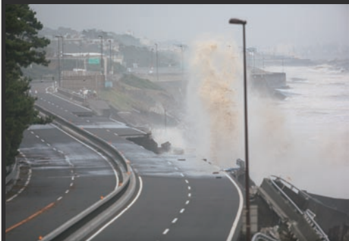
（写真：国土交通省関東地方整備局横浜国道事務所ホームページより）
